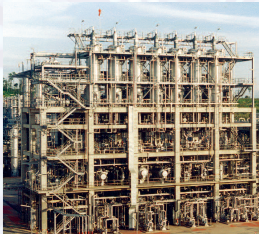
Самая большая в мире многоступенчатая вакуум-выпарная установка для производства мягких и твердых восков
